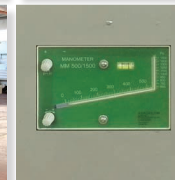
4 Pressostato controllo intasamento filtri. Pressure switch for filter clogging control.
